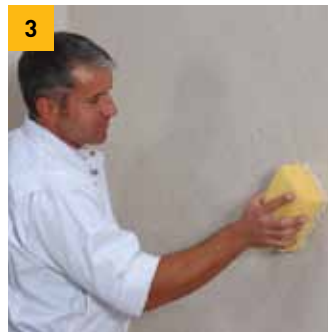
3. Нанесување и мазнење на малтерот
