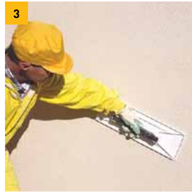
3. Финалниот слој може да се доврши со други слоеви или силикатна фасада придржувајќи се до упатствата на производителот.
