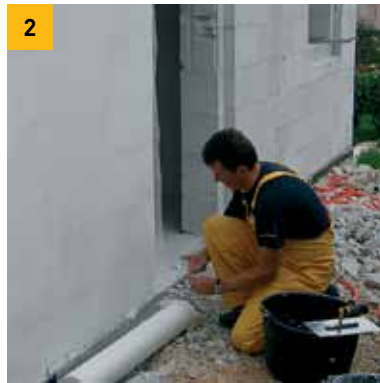
2. Поставување на мрежа врз првиот слој
