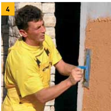
4. Нанесување и мазнење на финалниот слој – фасадата.
