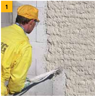
1. Нанесување (прскање) на масата
