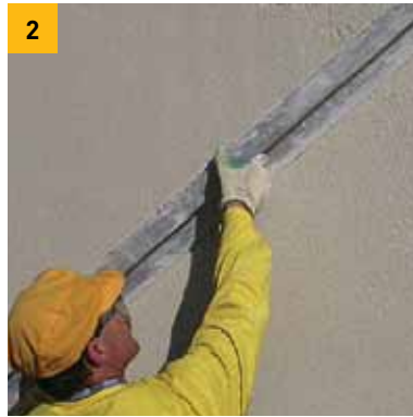
2. Надворешното малтерисување се израмнува со алуминиумска рамналка и нема потреба да се армира со мрежа
