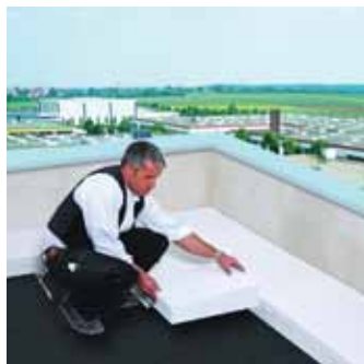
Поставување на YTONG Multipor на под
