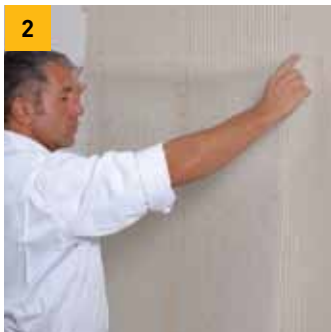
2. Поставување на армирана мрежа
