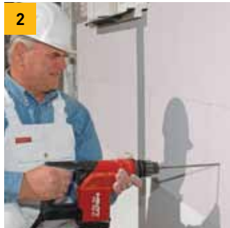
2. Отворање на дупки за типли
