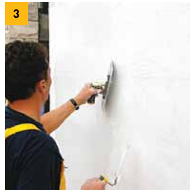
3. Распростирање и мазнење на вториот слој при што мрежата потполно се покрива, 1-2мм
