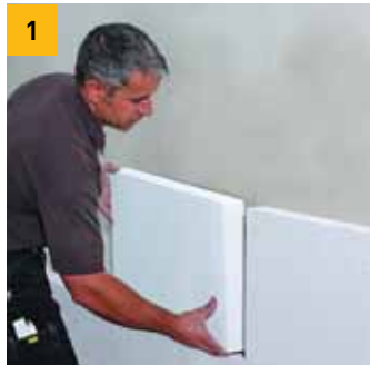
1. Редување на плочите на ѕидот
